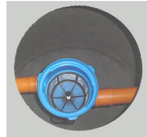
Blick durch die Einstiegsöffnung im Konus
